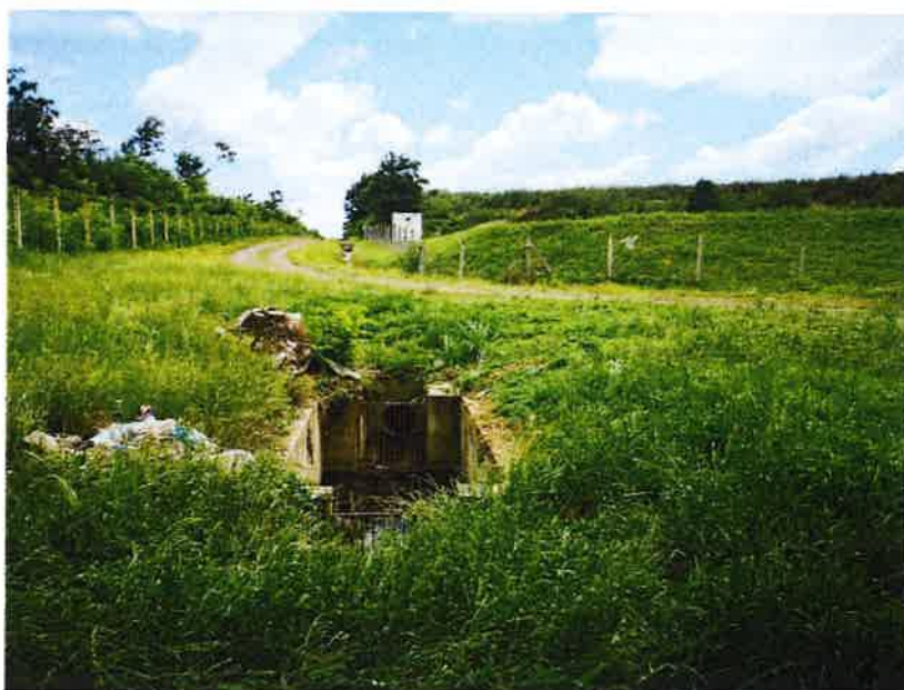
Slika 3. Taložnica na odlagalištu otpada „Vinogradine“ i ulaz za otpadnu vodu (kontrolno okno V-2)
